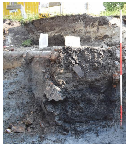
Afbeelding 5.13: Bakstenen put S6 (links de mantel en rechts doorsnede). De gresbuis is duidelijk aangesloten op de put. Bron: Vestigia.
