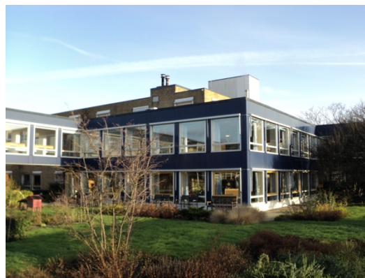
Het centrale deel bevat rondom gevelbeplating.
