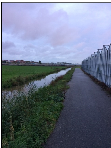
Foto 9: westelijke watergang, inclusief asfaltpad
