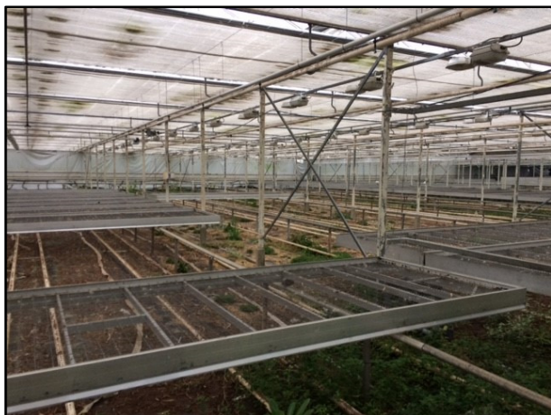
Foto 1: inpandig, kas (deellocatie E)
