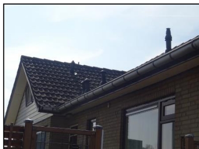
Figuur 9. Dakpannen en goot bij de woning aan de zuidkant van de onderzoekslocatie.
