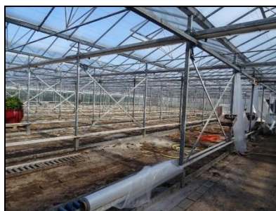
Figuur 4. Binnenkant van een van de kassen op de onderzoekslocatie.
