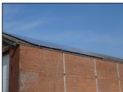
Figuur 12. Golfplaten en zonnepanelen op het dak van de centraal gelegen schuur. Bakstenen gevel.
