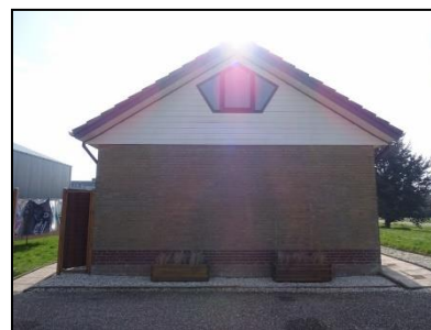
Figuur 5. Noordgevel van de woning aan de zuidkant van de onderzoekslocatie.
