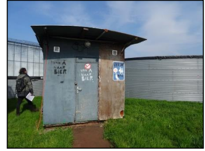
Figuur 17. Keet met houten betimmering waarin enkele openingen aanwezig zijn.
