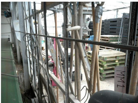
Foto 15. Asbesthoudende kaskit op gevelroeden (bron Bron1)
