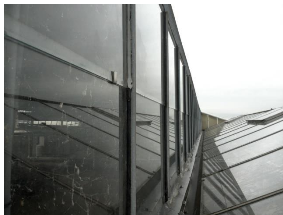
Foto 18. Asbesthoudende kaskit op gevelroeden (bron Bron1)
