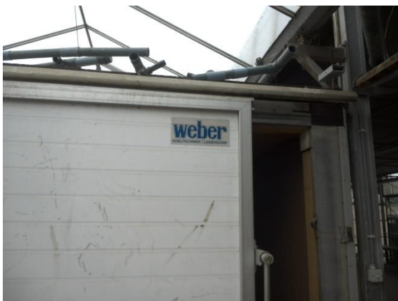
60. Koelcel in bedrijfsruimte 3
