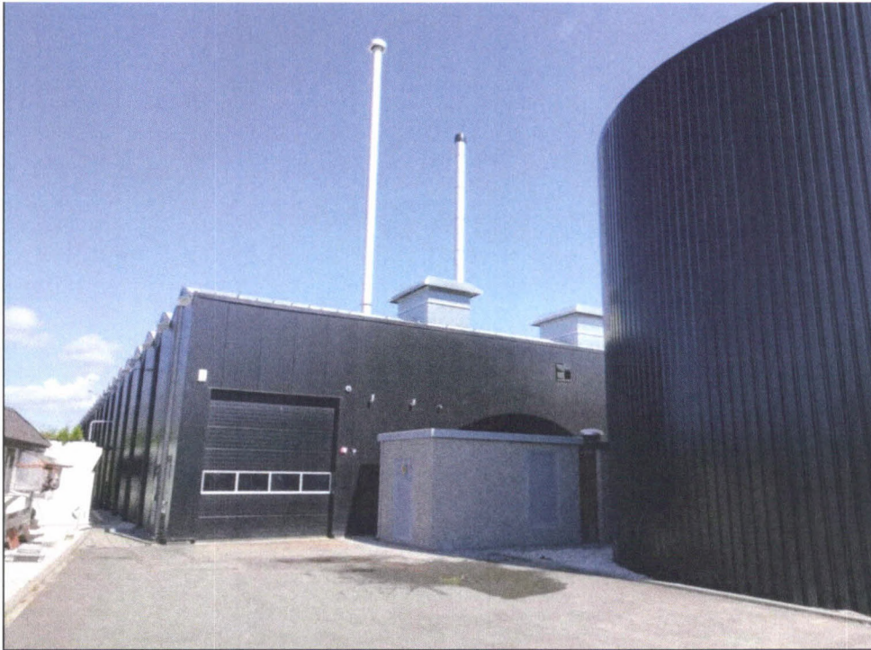
Figuur 14: Bijlage 3. Foto van de loods achter de WOT, waarin zich de WKK-installatie bevindt. Bron: Looije Agro Technics.
