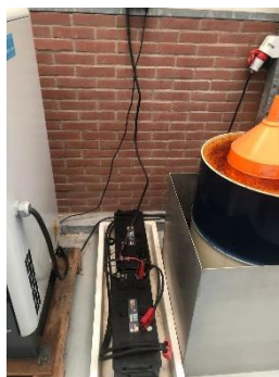
Foto 8: Accu i.v.m. aggregaat
