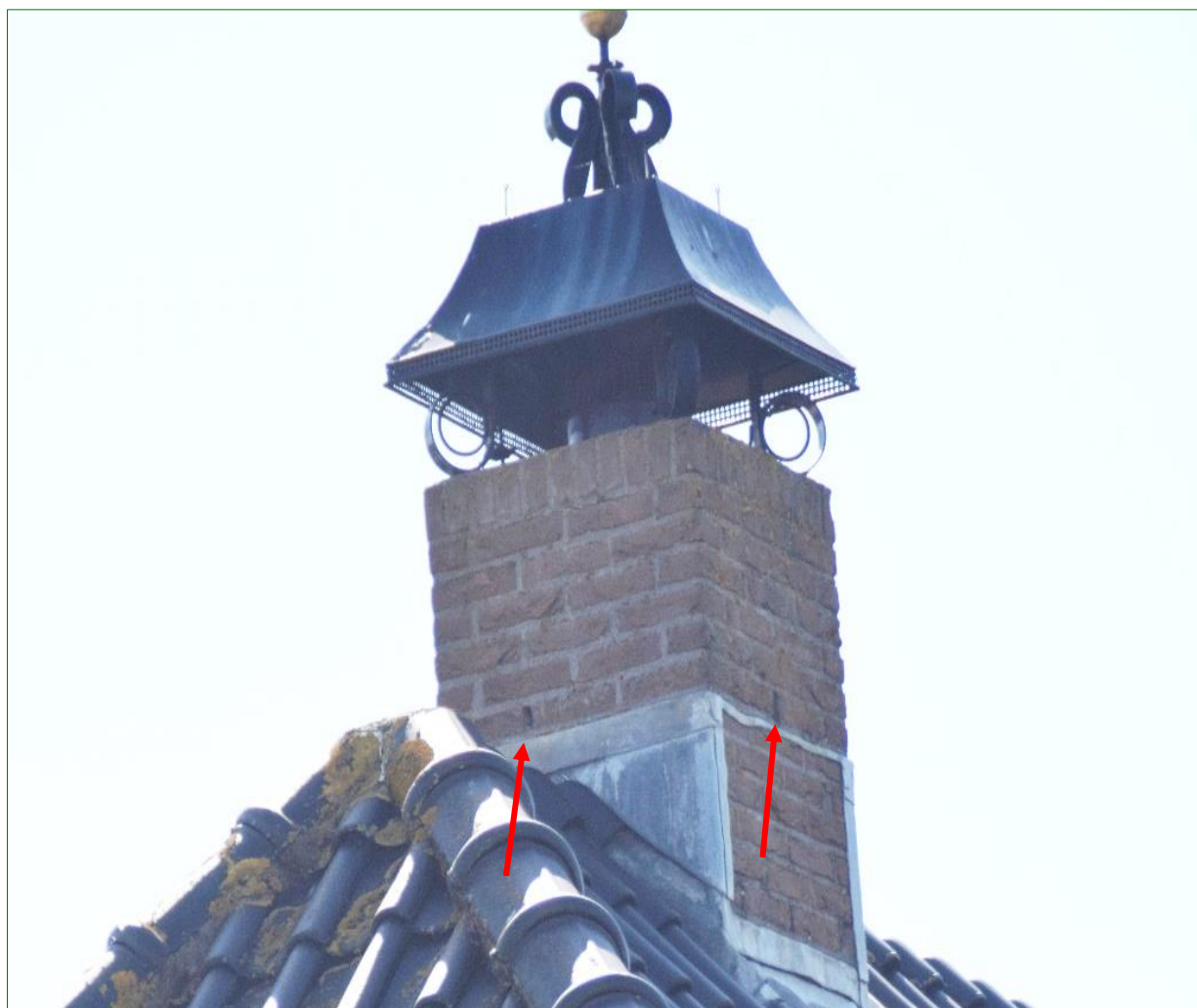
Open stootvoegen geven vleermuizen toegang tot geschikte ruimten.
