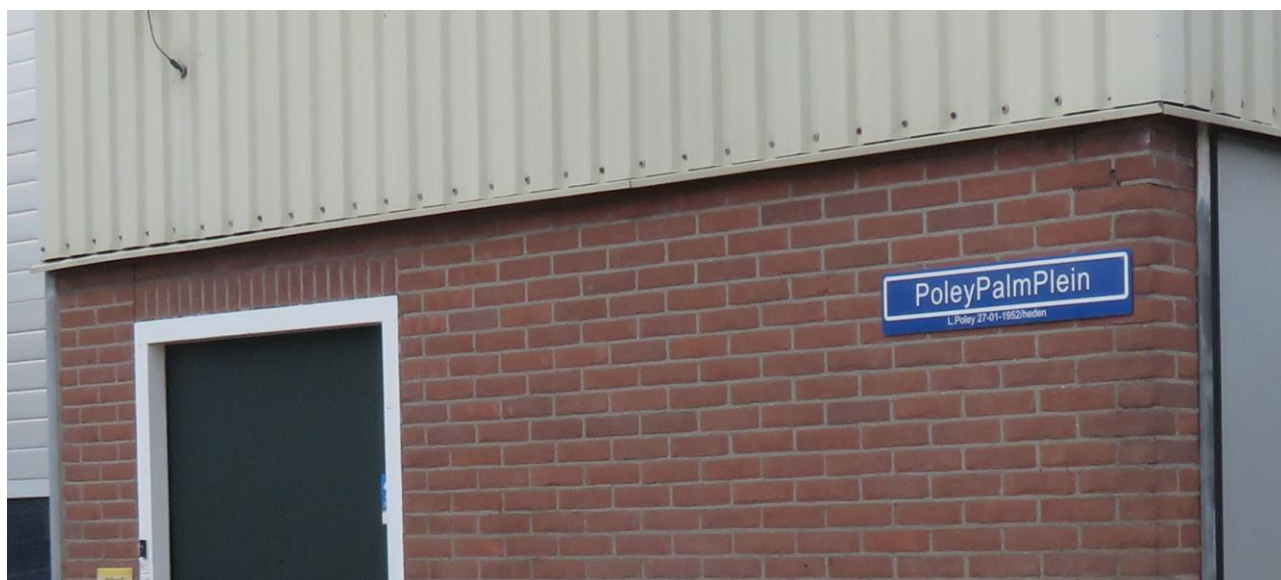
Afbeelding 4: Close-up waarop te zien is dat alle naden goed aansluiten.
