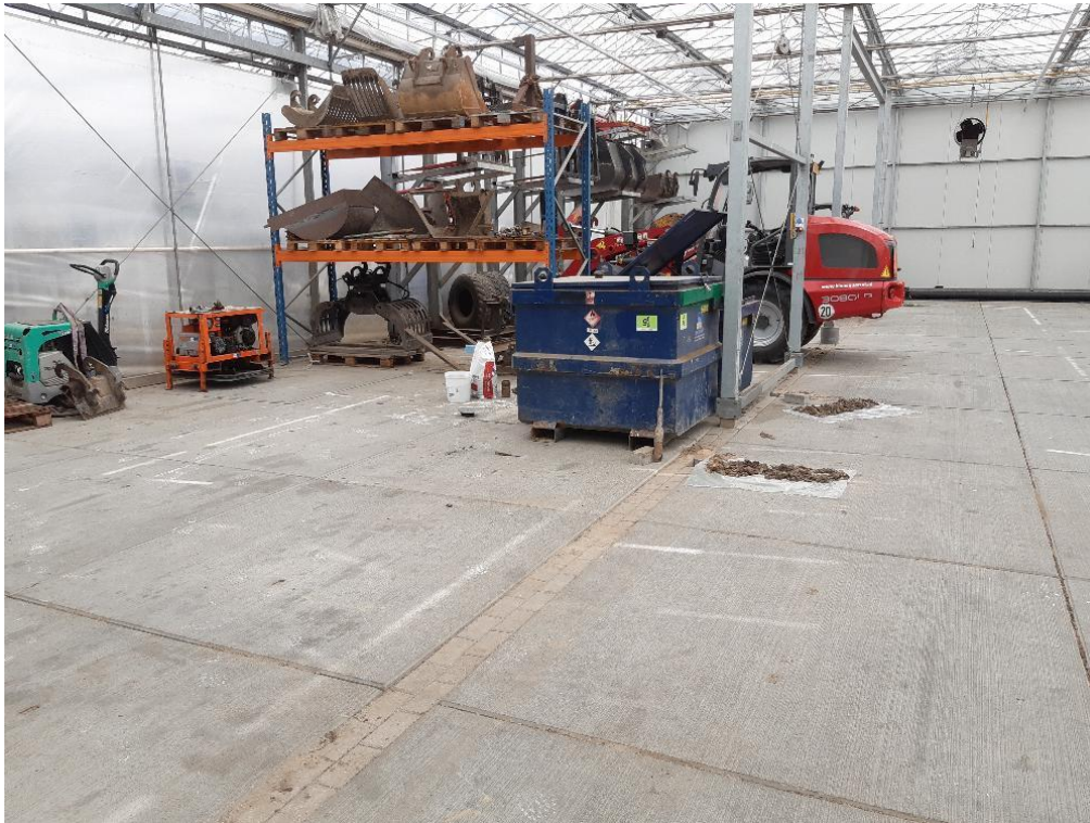
Foto 3: bovengrondse tank in lekbak in bedrijfshal
