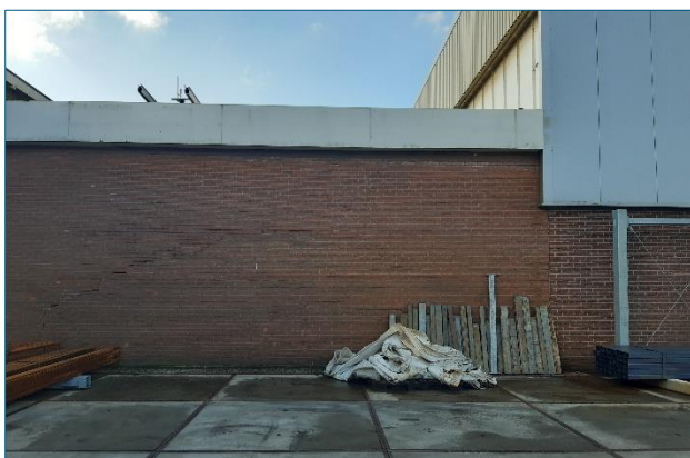
Figuur 2-4: te slopen "corridor" (links) en detailopname van de muur (rechts), de muur is goed afgehecht, er zijn geen voor vleermuizen geschikte openingen of andere kieren aanwezig, wel is op heuphoogte een scheur aanwezig, die geen toegang verleend tot de achterliggende spouwmuur (zie inzet, visuele controle ten tijde van het veldbezoek).
