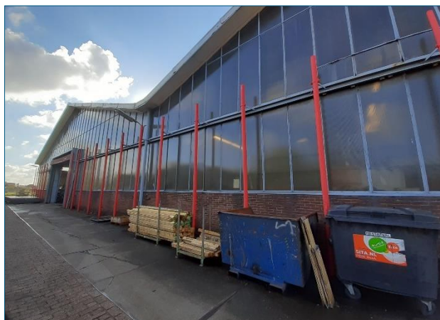
Figuur 2-6: noordgevel van de te slopen bebouwing (links) en detailopname van deze gevel, het onderste gedeelte bestaat uit een enkel-steens muur, met daarboven een glazen wand en direct daarop het dak (rechts, zie ook Figuur 2-7 hieronder).
