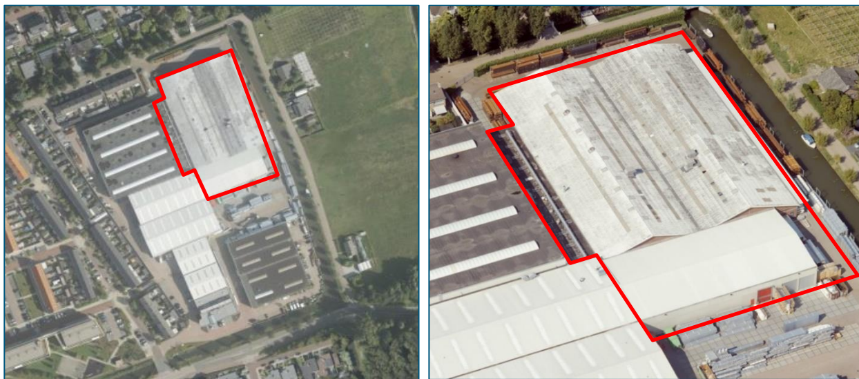
Figuur 2-11: Huidige situatie en weergave van de te slopen bebouwing (rode lijn, bron afbeeldingen: Cylcomedia).
