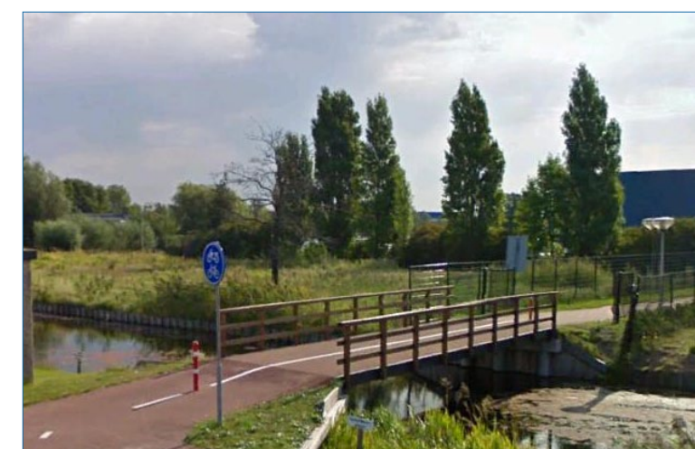
Houten fietsbrug in fase I
