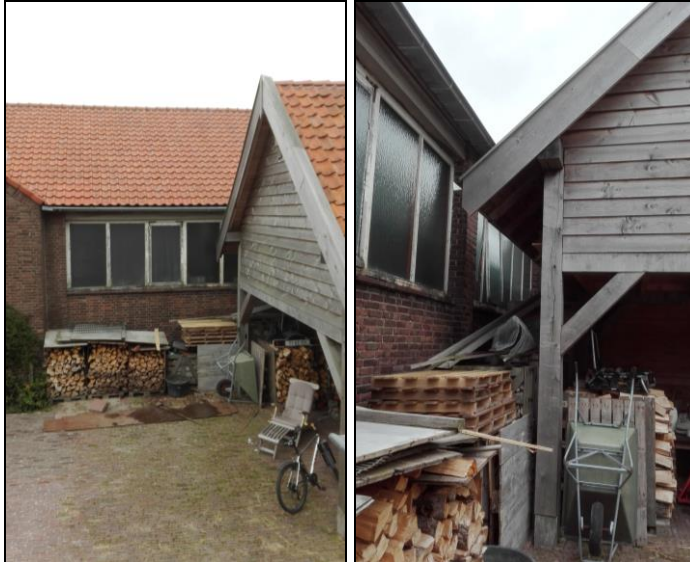
Figuur 5.2. Links: zicht op de achterzijde van de showroom vanuit de invliegopening van de westelijke schuur. Rechts: de ruimte tussen de oostelijke schuur en de te slopen showroom.
