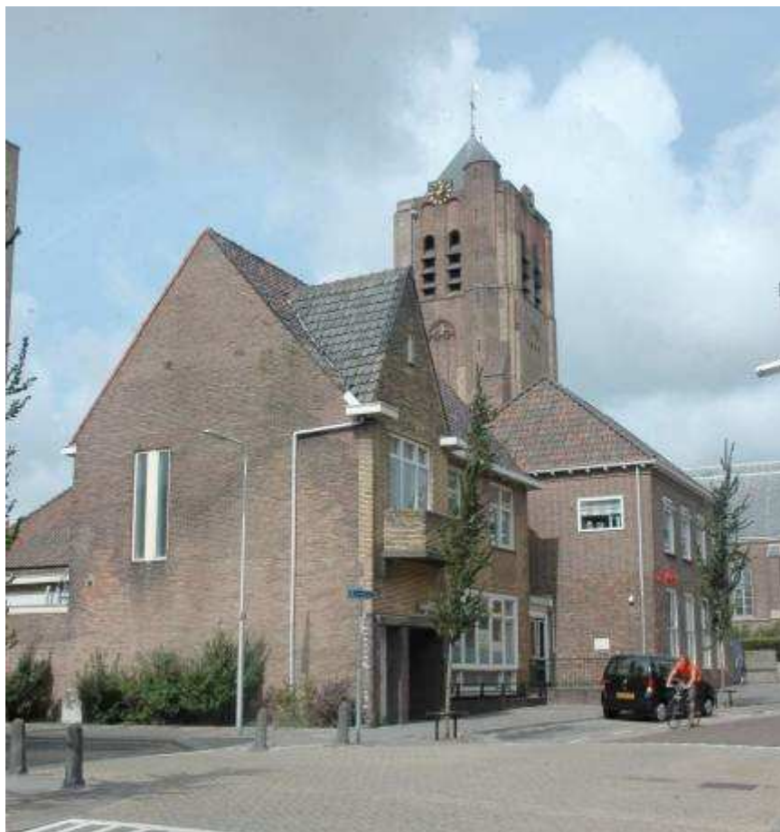
Sprongen in het profiel en aandacht voor de hoek
