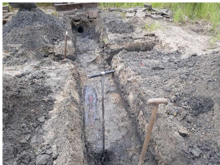
foto 5: olietank bij sleuf 2
