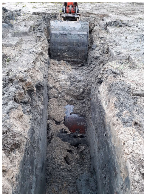
foto 6: olietank bij sleuf 2
