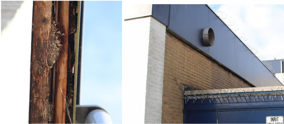
Figuur 5.1. De dakrand aan de voorzijde (zuidzijde) waar duidelijk te zien is dat het volledig afgesloten is. De dakrand aan de achterzijde (noordzijde), onder de boeiboorden is een stenen rand aanwezig waardoor de mogelijke ruimte hier tussen ontoegankelijk is.
