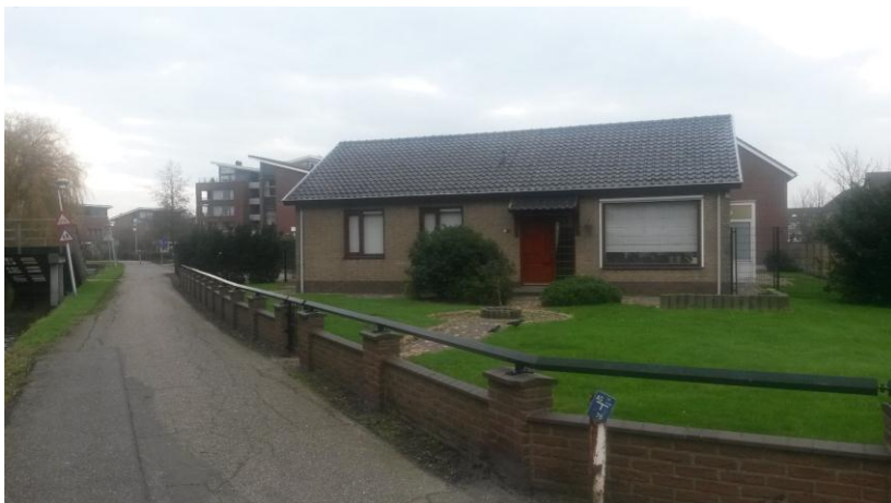
Foto 1. Voorzijde van de bestaande woning welke wordt gesloopt
