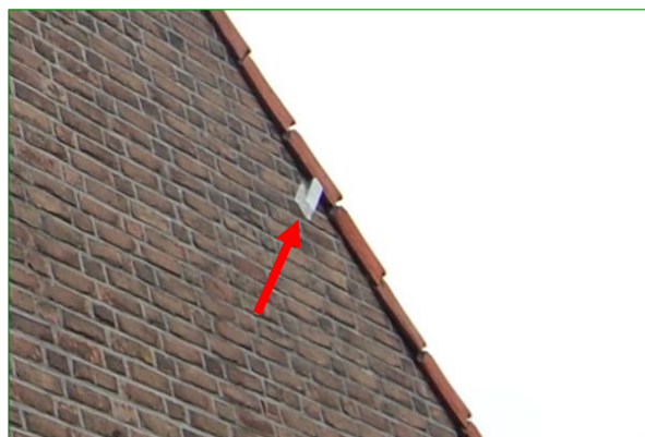
Geplaatste exclusion flap onder dakpannenrand zijgevel Van der Goesstraat 71.
