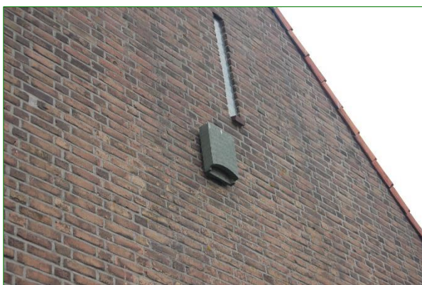
Vleermuiskast aan zijgevel Van der Goesstraat 71.
