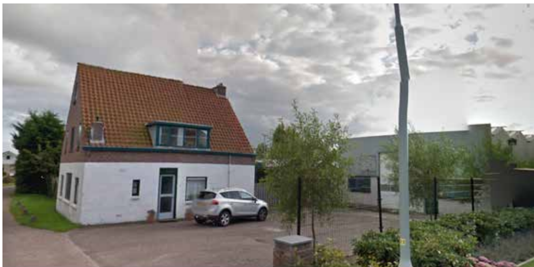
Het woonhuis en de kas (met stalen voorgevel)
