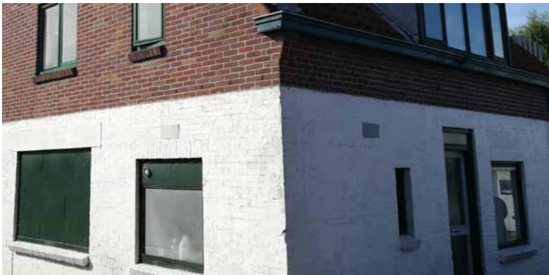
Afdichting van ventilatieroosters
