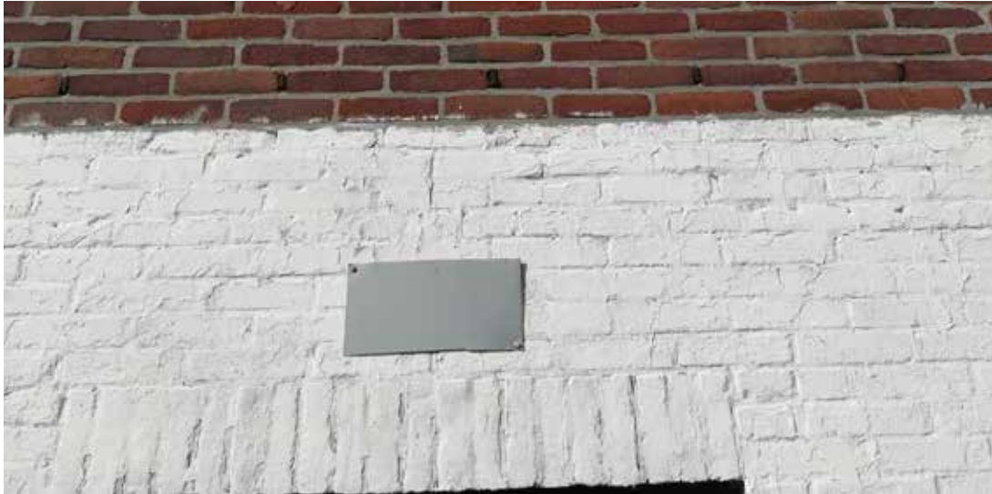
Afdichting van ventilatieroosters
