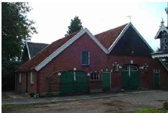
Foto 1 (boven): de te slopen schuur. Foto 2 (onder): de te renoveren schuur van de boerderij. (Bron: Te Kieft Architecten).
