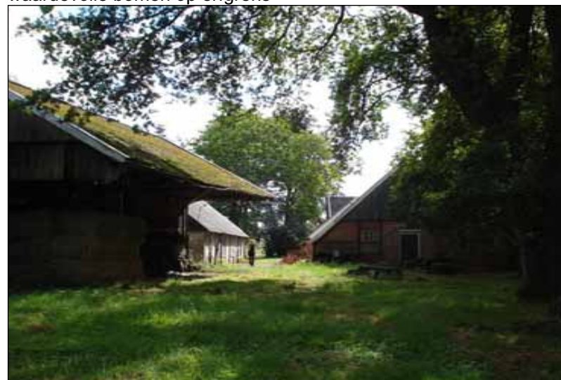
13. Eenvoudige dakvlakken, geen samenhangend geheel
