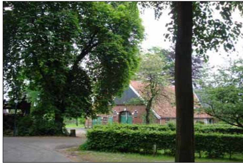
1. Markante ligging aan het Stift, toegang vanaf de Stiftstraat
