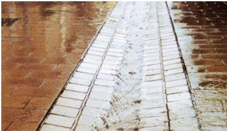
Figuur 5: voorbeeld van een goot voor oppervlakkige afstroming
