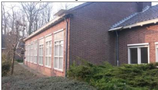
Foto 4 voorzijde voormalige school
