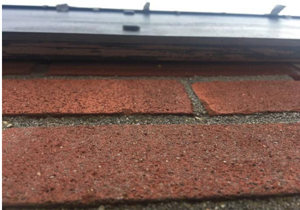
De boeiboorden van de te slopen bebouwing, sluiten nauw aan op de buitengevels.
