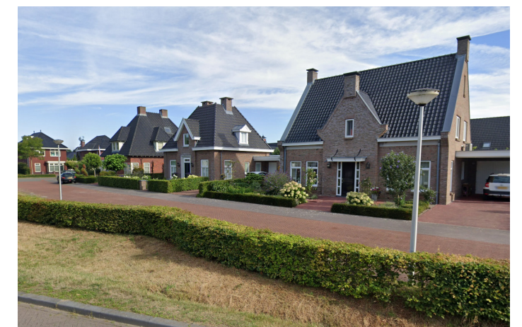
Aansluiten bij de traditionele architectuur van Denekamp
