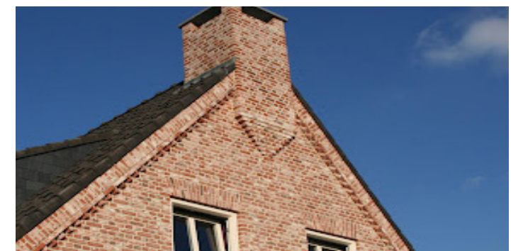
Siermetselwerk (Bron: Bouwbedrijf Ros)
