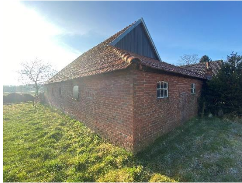
Het later uitgebouwde eindschot aan de achterzijde
