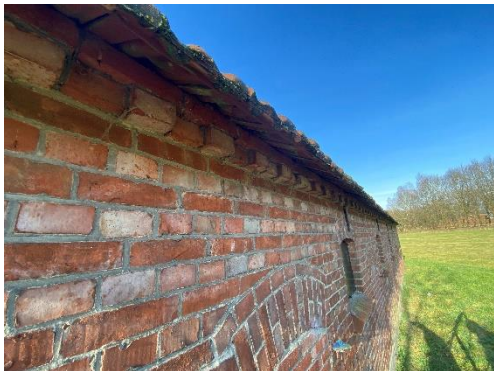
Uitgemetselde bloktand onder de muurplaat
