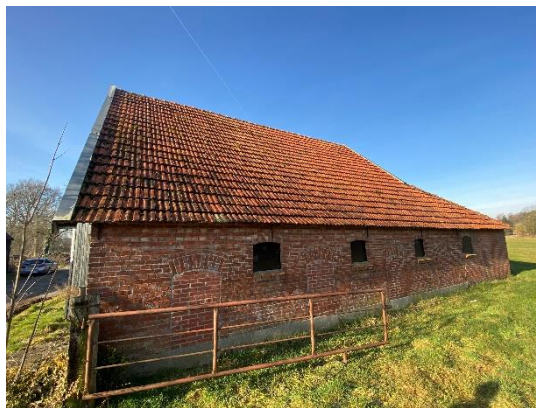
Rechter zijgevel met dichtgemetselde varkensdeurtjes
