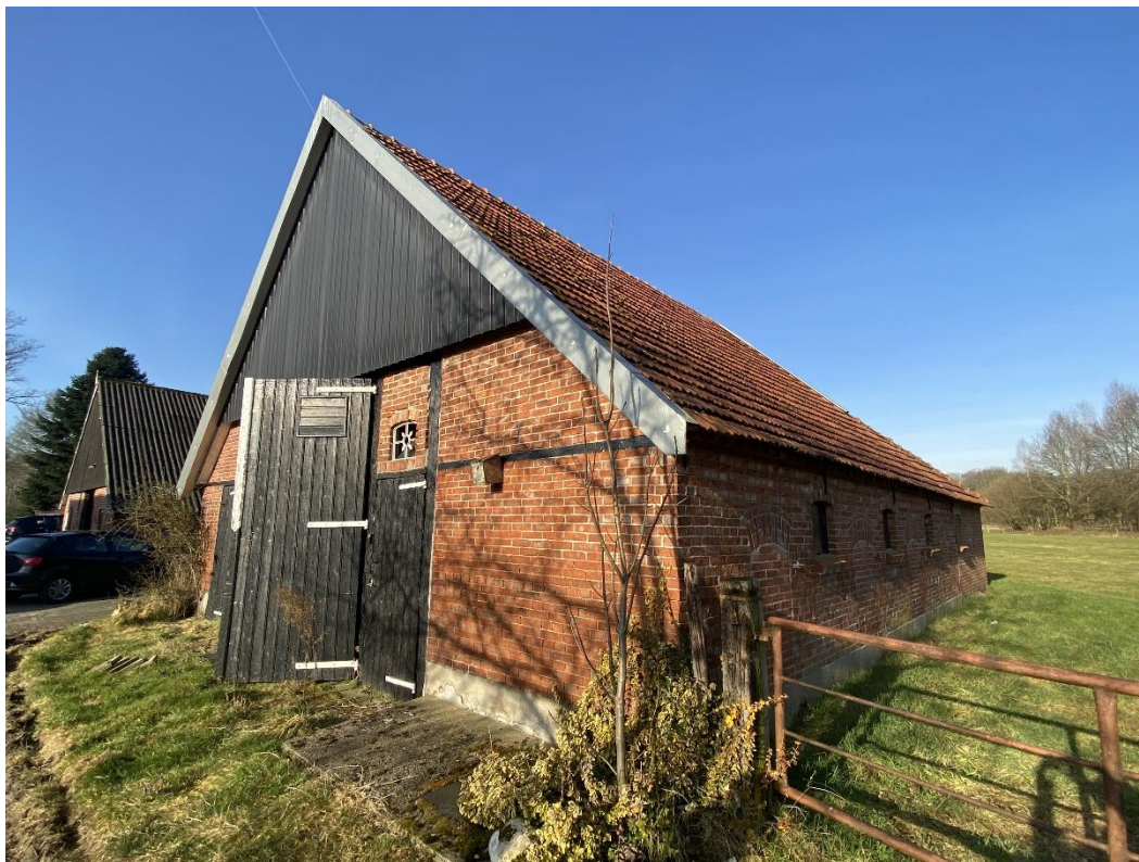
De naar de straat gerichte gevel van de schuur
