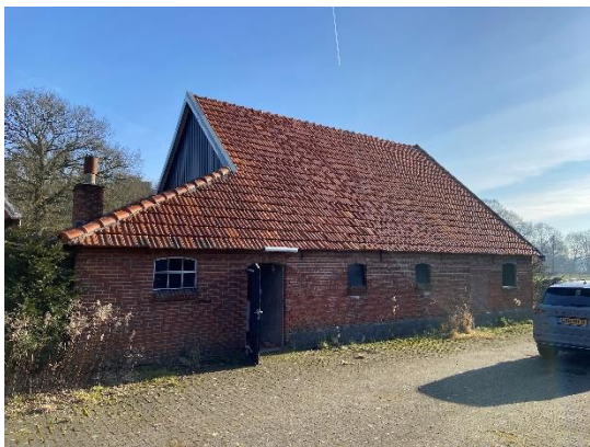
Linker zijgevel schuur met het kenmerkende eindschot
