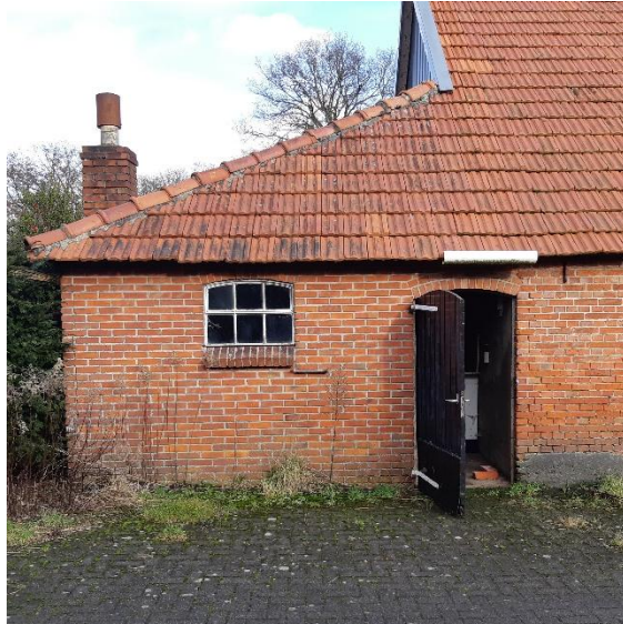
Aansluiting uitbouw linkerzijgevel
