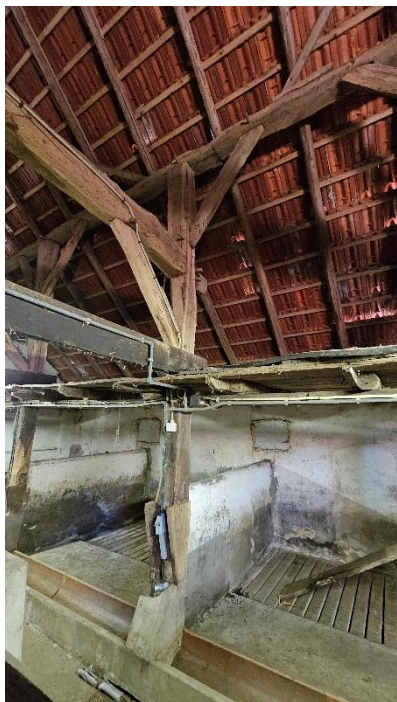
Ankerbalkgebinten met sporenkap
