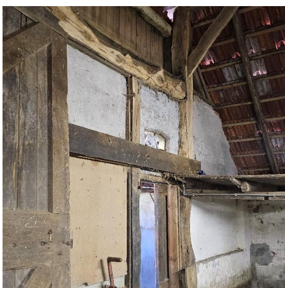
De oude vakwerkconstructie in de oorspronkelijke achtergevel inclusief de stalen stalraampjes.
