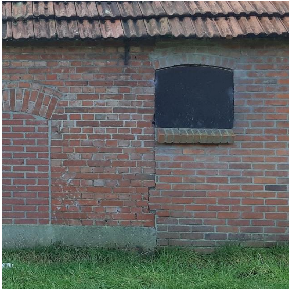
Aansluiting uitbouw rechterzijgevel
