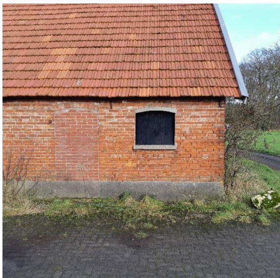
De vorm van de dichtgemetselde kozijnen zijn in de zijgevels aanwezig en te reconstrueren.
