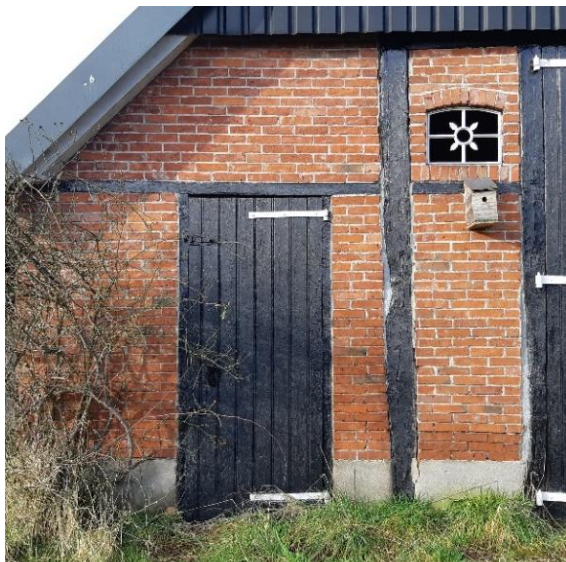
De staldeuren en de ingemetselde stalen stalraampjes in de voorgevel.
