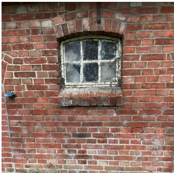
De stalen stalraampjes in de zijgevels en de achtergevel.
