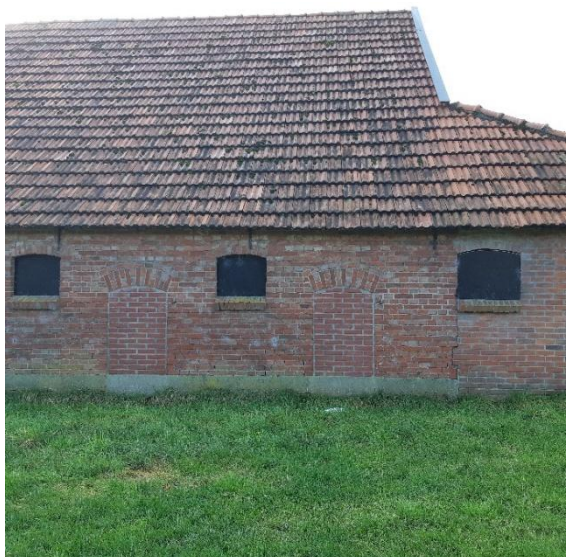
De vorm van de dichtgemetselde kozijnen zijn in de zijgevels aanwezig en te reconstrueren.
