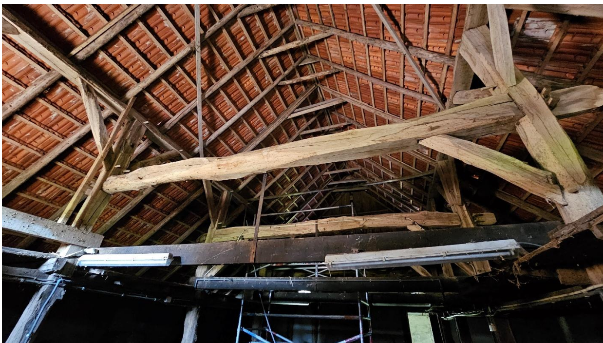
Wijzigingen die in het verleden zijn aangebracht aan de constructie
