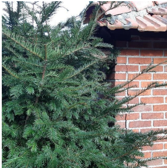
Detail scheurvorming achtergevel uitbouw
