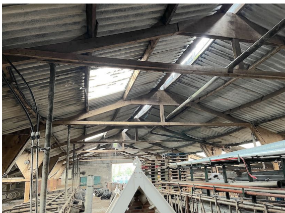
Figuur 13. Binnenzijde ligboxenstal.
