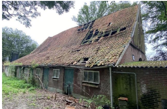
De rechterzijgevel met rechts de aanbouw
