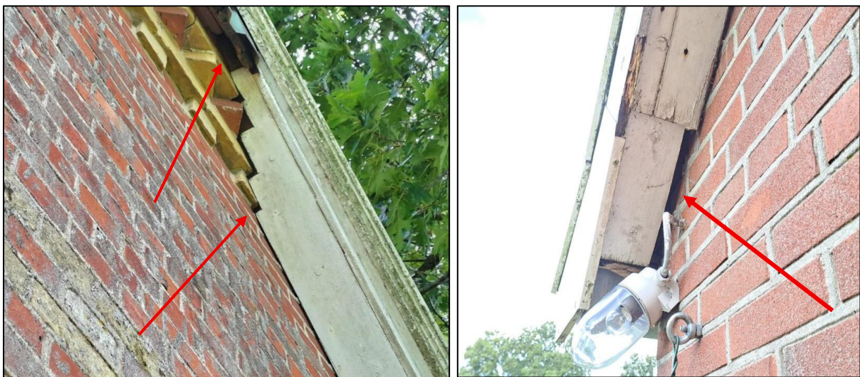
Foto 3 en 4: kieren achter de topgevel en dakoverstek van de boerderij.
