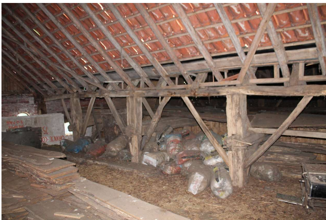
Eiken gebintwerk met de sporenkap ter plekke van de zakgoot
