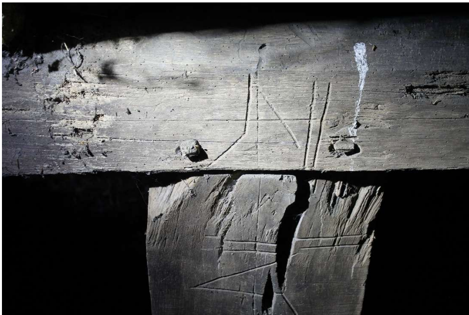
Telmerk no. 7 in de gebintstaander en bovenplaat
