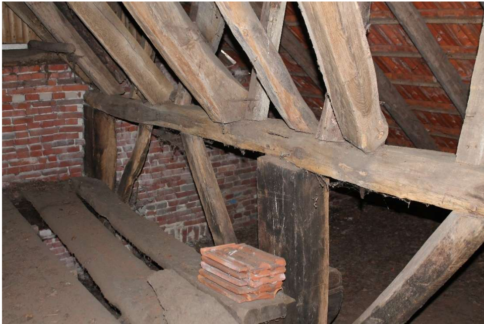
Gebintwerk op zolder met bovenplaat waarop de daksporen staan
