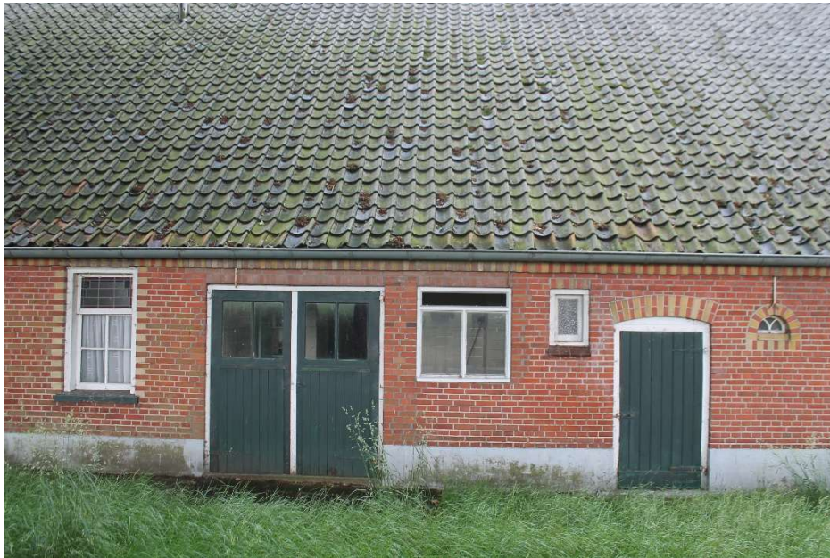
Foto noordgevel met later aangebrachte zijdeuren en betonnen stalraam
