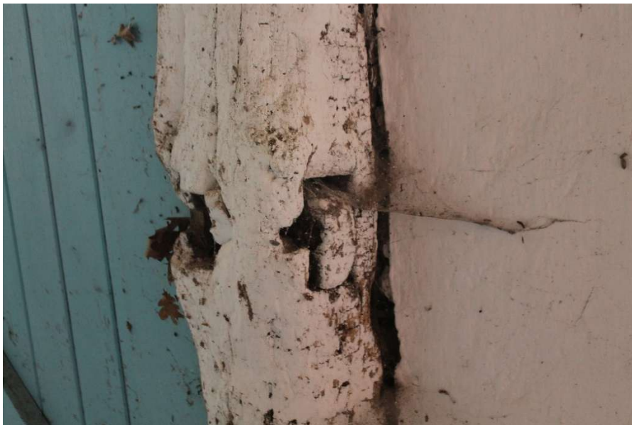
Oude eiken gebintstaander met oude vakwerkverbinding binnenzijde achtergevel
