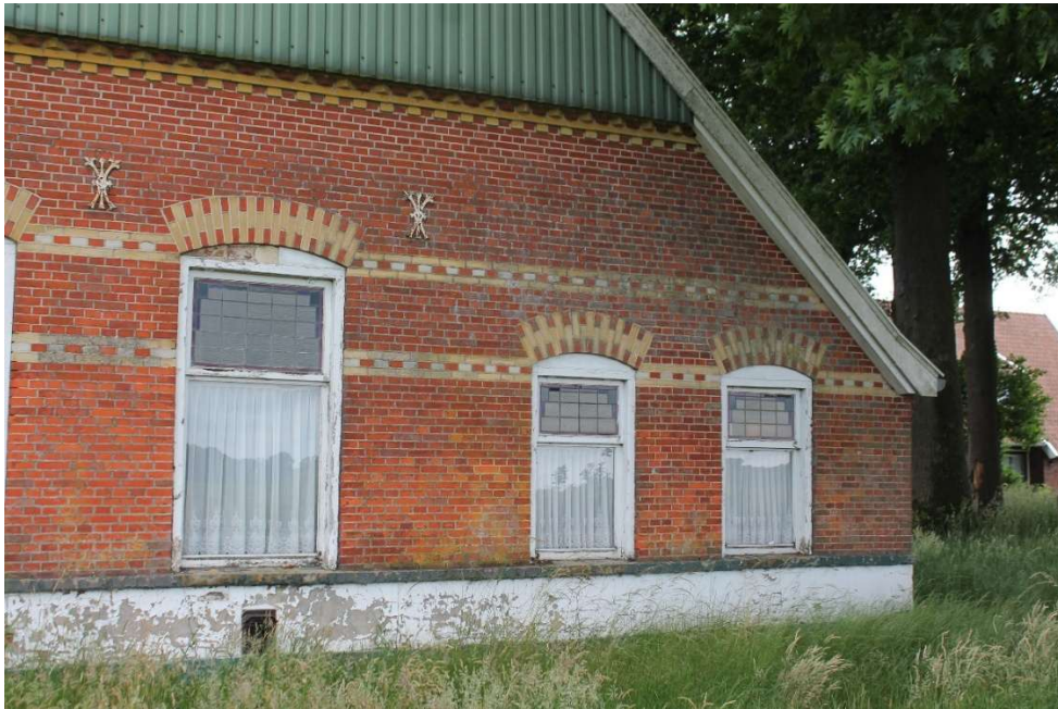
Voorgevel boerderij met siermetselwerk met verblendstenen
