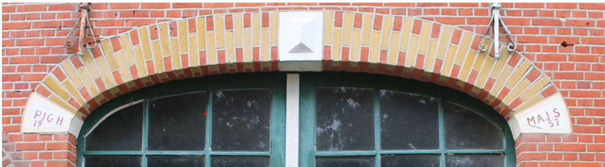
Niendeuropening achtergevel met jaartal 1957 toen het onderschoer vermoedelijk is verdwenen
