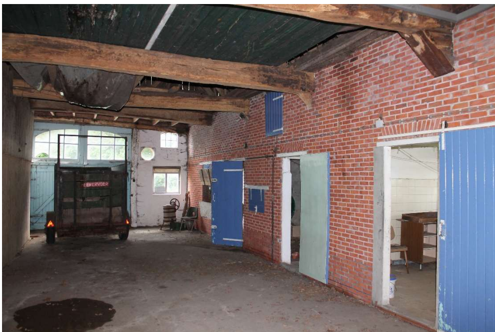
Deelruimte met oude binnenmuur
