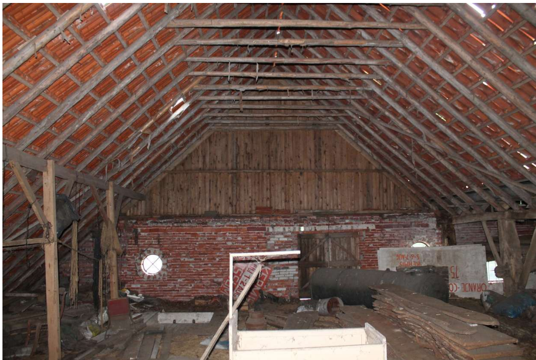
Rondhouten grenen sporenkap boven de aanbouw
