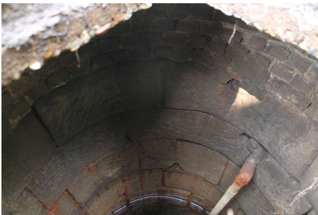
Zandstenen waterput nog aanwezig bij het voorhuis, afgedekt met betonplaat
