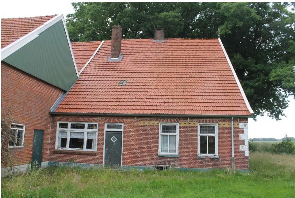
Foto westgevel met keukenkozijn uit de jaren 60
