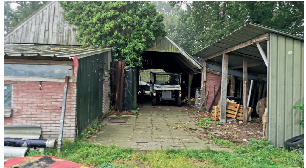
Figuur 2. Te slopen opstallen
