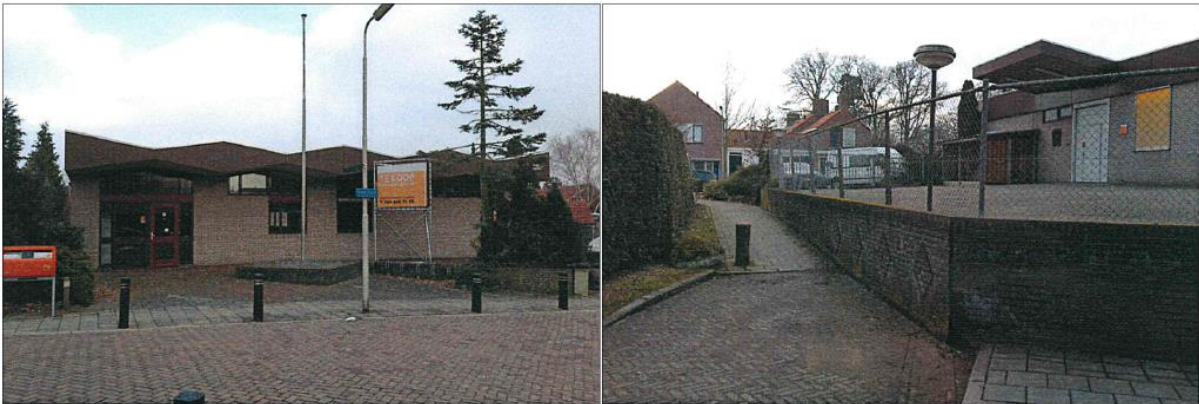
Afbeelding 2.3: Het gebouw gezien vanaf de Parkstraat (links) en het terrein/gebouw gezien vanaf de aangrenzende gronden ten noordoosten van het projectgebied (rechts)
