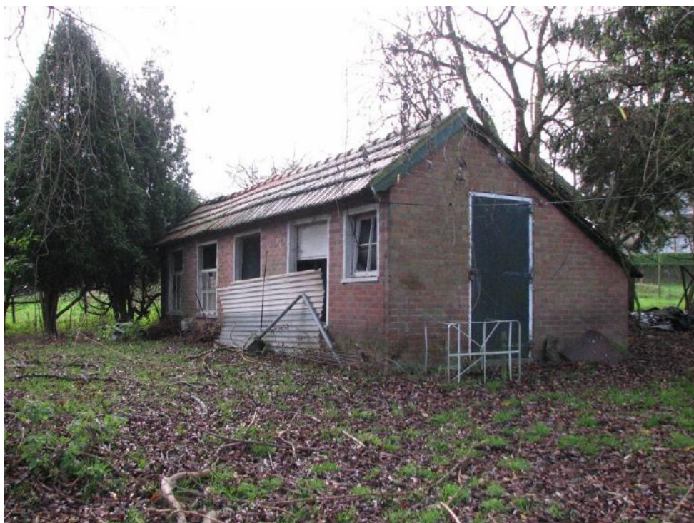
Foto 11: Te slopen schuur.
