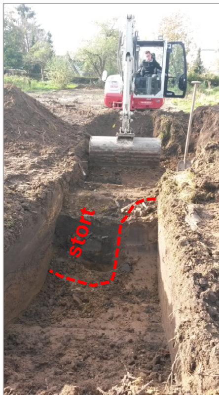
Sleuf 2, noordzijde stortgat. Gezien richting het westen.
