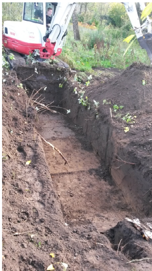
Sleuf 4, gezien richting oosten, zuidelijk van het stortgat. Geen stort aanwezig.
