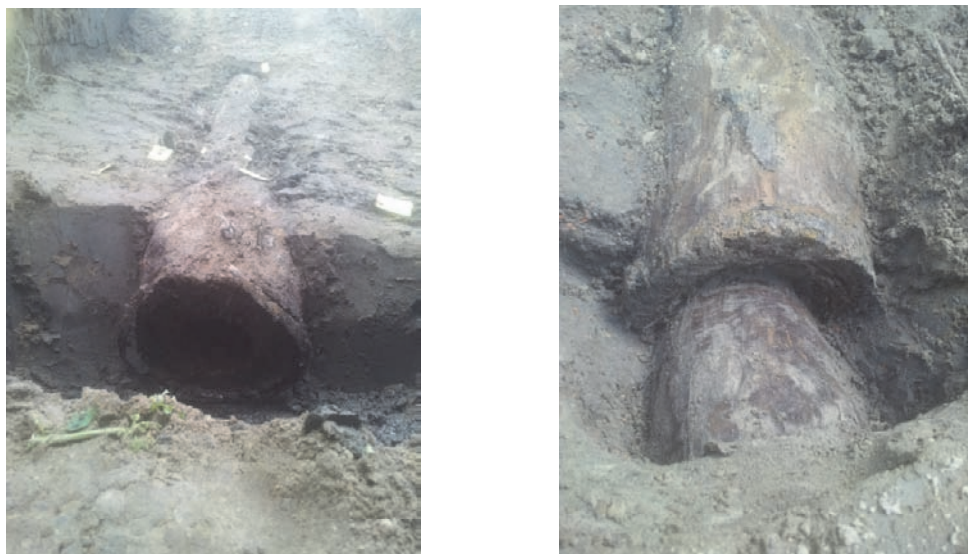
Fig. 6.18: De waterleiding ter plaatse van de uitmonding in de molenvijver en de aansluiting van de 2° aan de 1° buis (geteld vanaf de monding).
