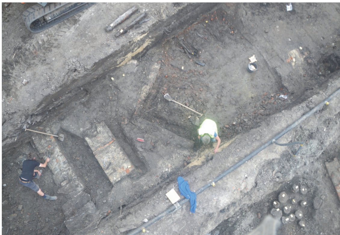
Fig. 6.8: Het vrijleggen van de (houten) funderingen in wp4. Zichtbaar zijn structuur 5 en delen van structuur 6, 22 en 23 (vergelijk met Bijlage 3).
