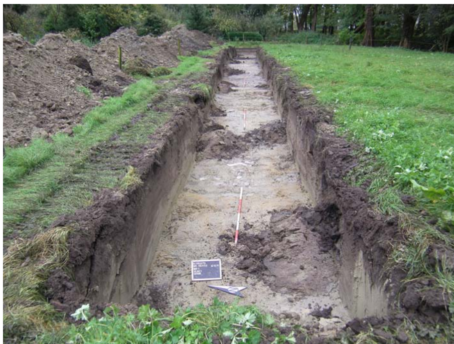
Afb 3.01 Inklappende profielwanden in WP 1 direct na aanleg.
