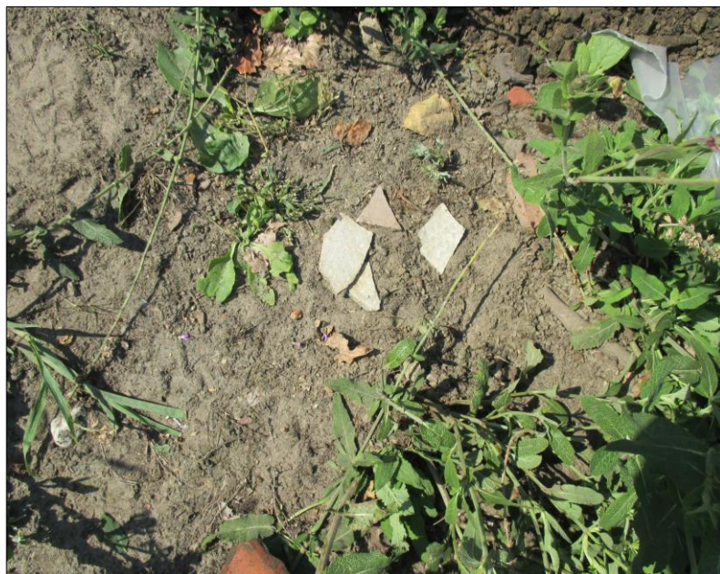
Afbeelding 4.1: Aangetroffen asbestplaatjes tijdens de maaiveldinspectie op 26 juli 2018.
