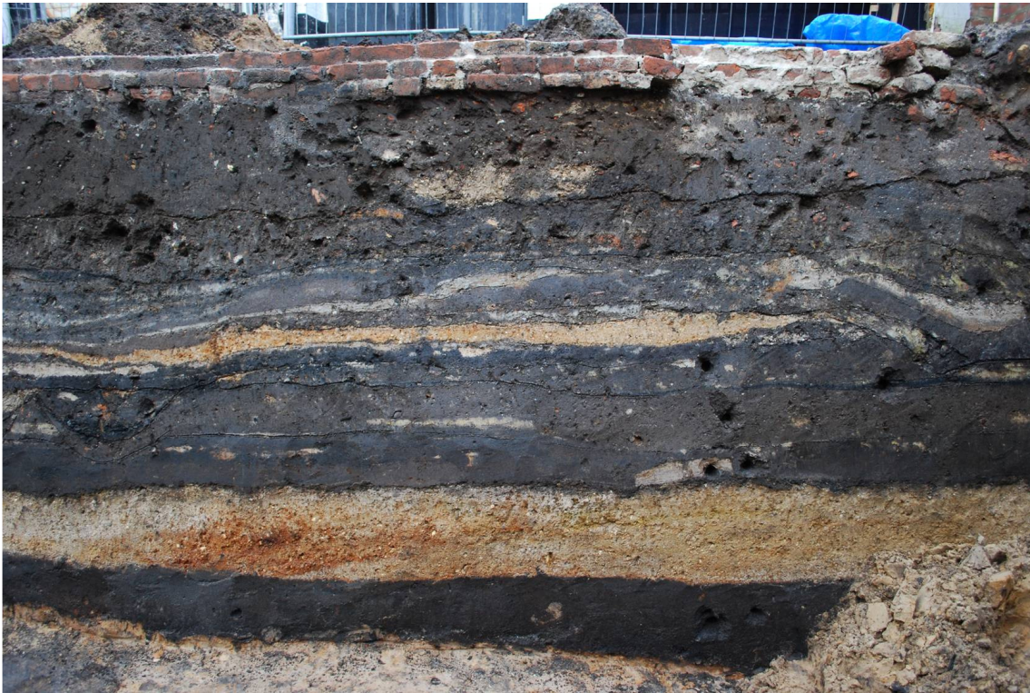
Figuur 2. Voorbeeld van een bodemopbouw in een binnenstedelijke context. Duidelijk zichtbaar zijn de zeer abrupte overgangen tussen de diverse lagen en de natuurlijke ondergrond.
