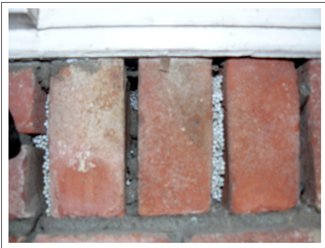
Foto 3. De spouw is geïsoleerd met piepschuimkorrels.
