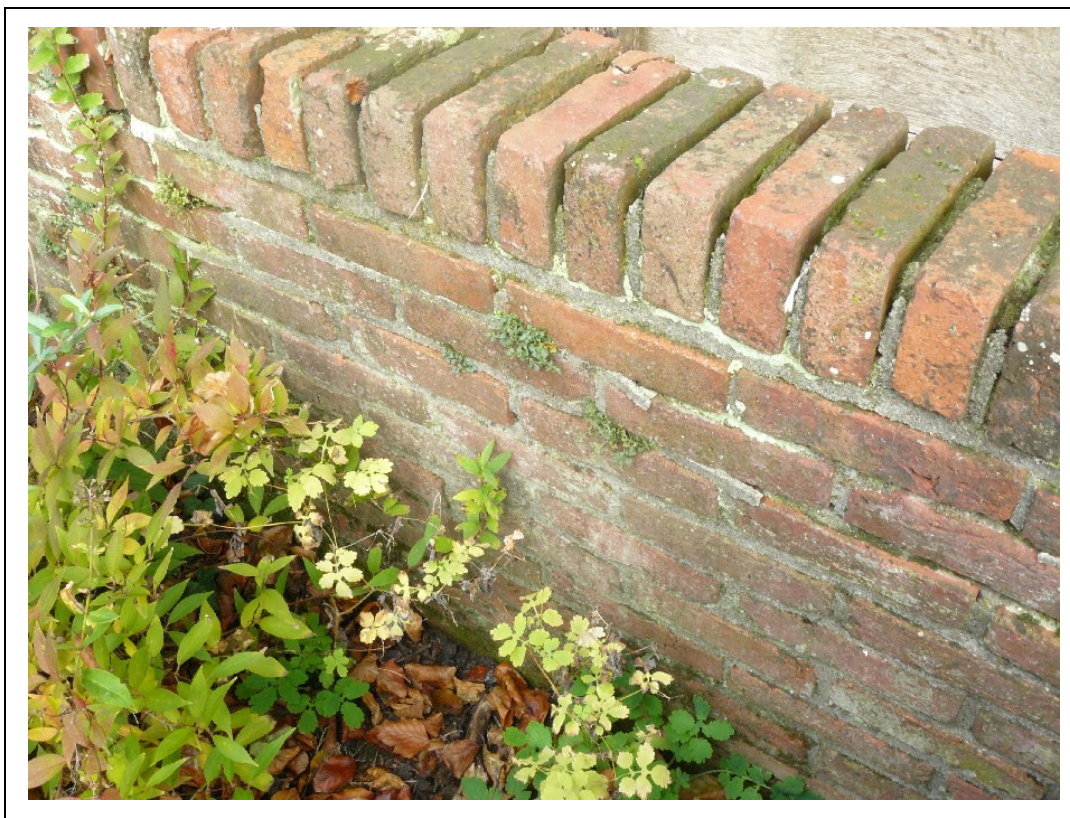
Foto 5. Muur met muurvaren aan noordzijde onderzoekslocatie.
