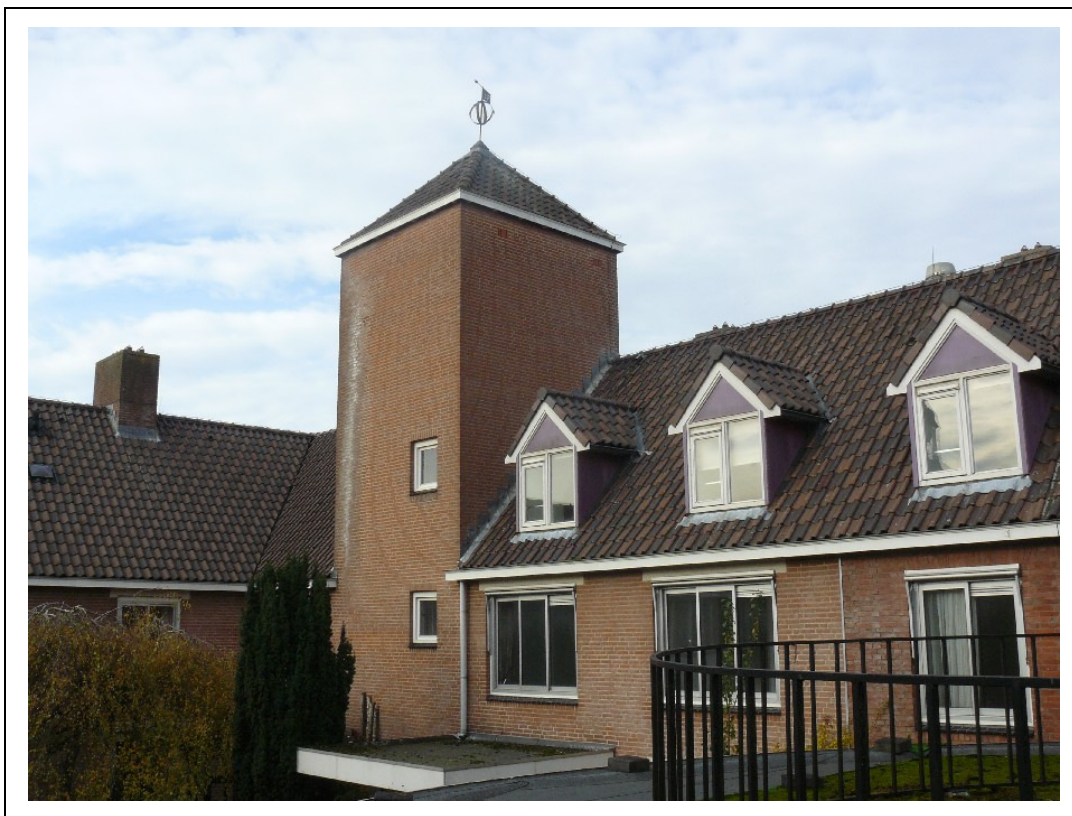
Foto 2. Toren met liftschacht.
