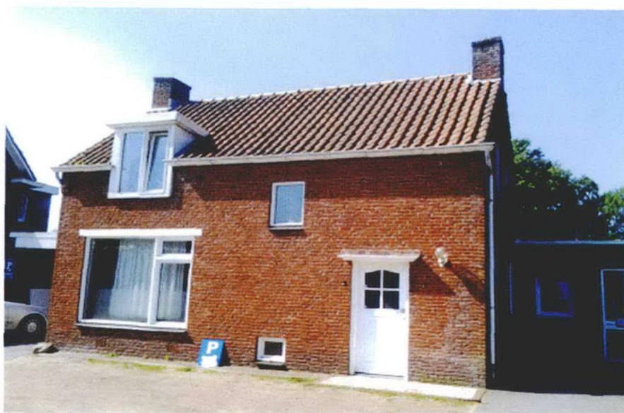
figuur 3: gesloopte woning
