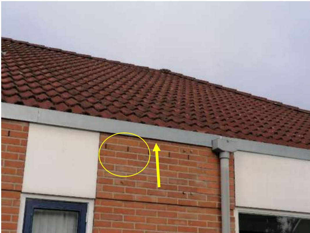
Zichtbare open stootvoegen vormen potentiële invliegopeningen in het gebouw
