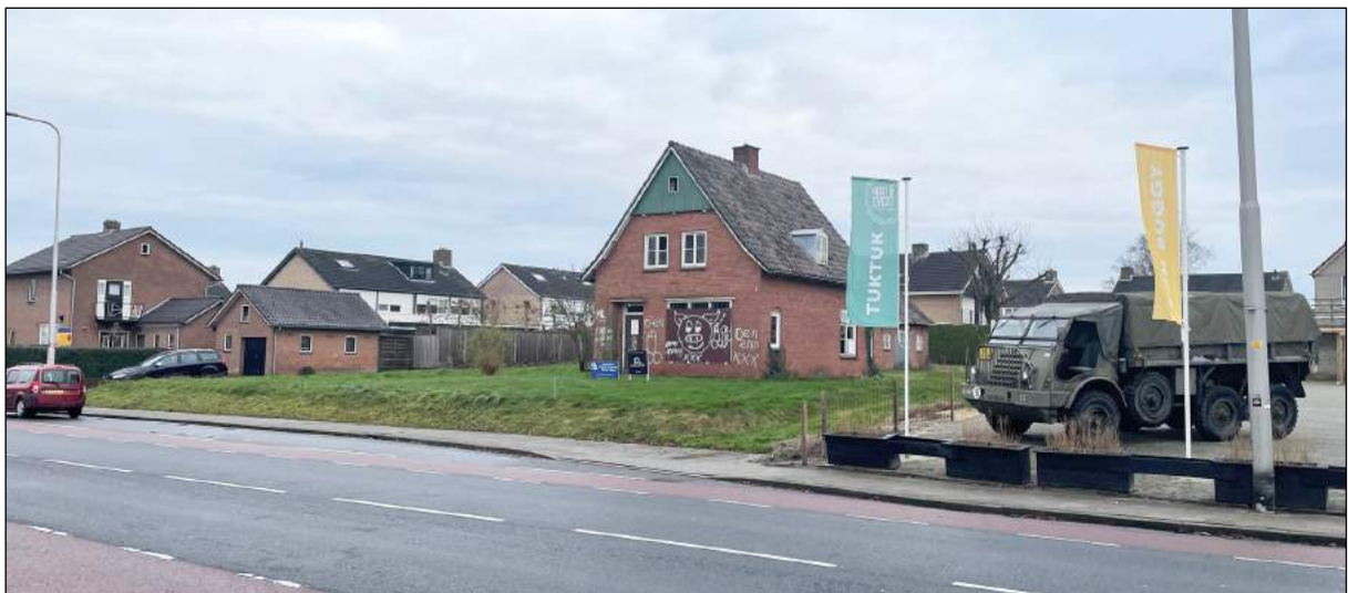
Huidige beeld van leegstaande woning aan de Denekamperstraat.
