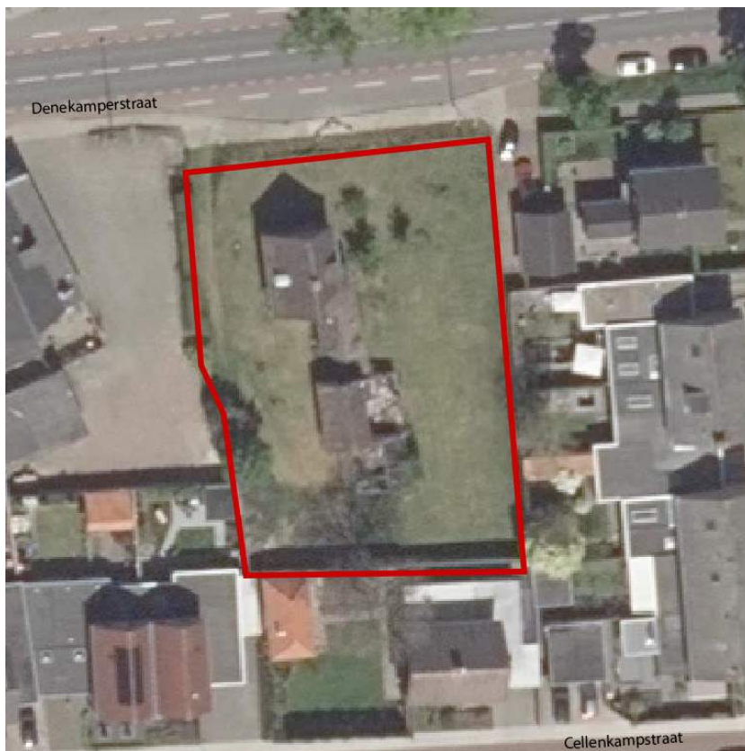
Luchtfoto van het plangebied aan de Denekamperstraat.
