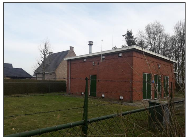
Gasontvangstation aan de Asterstraat
