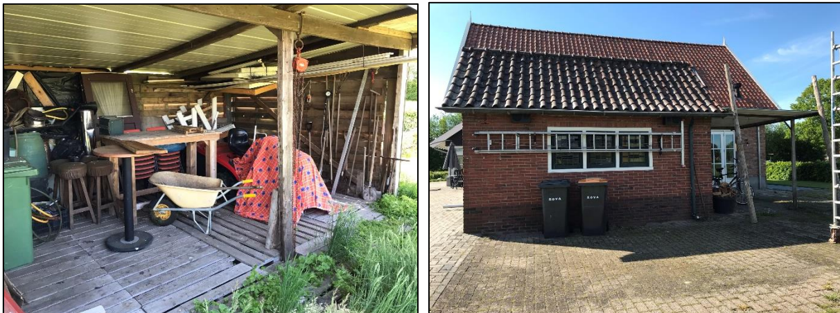
Figuur 1: Te slopen schuurtje. Links: schuurtje 1 die op de plek van de nieuwe schuur staat. Rechts: schuurtje 2 direct naast de woning.
