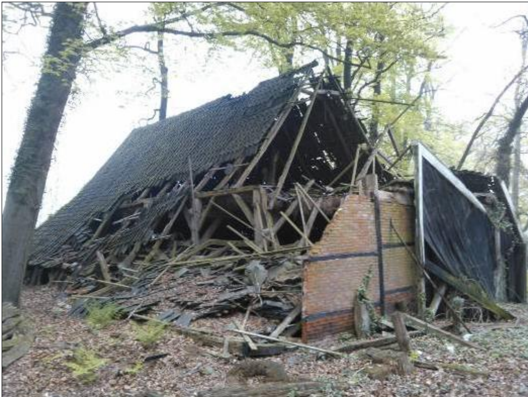
Afbeelding 2.1: Vakwerkschuur aan de Everlostraat 7 te Rossum (Bron: Provincie Overijssel)
