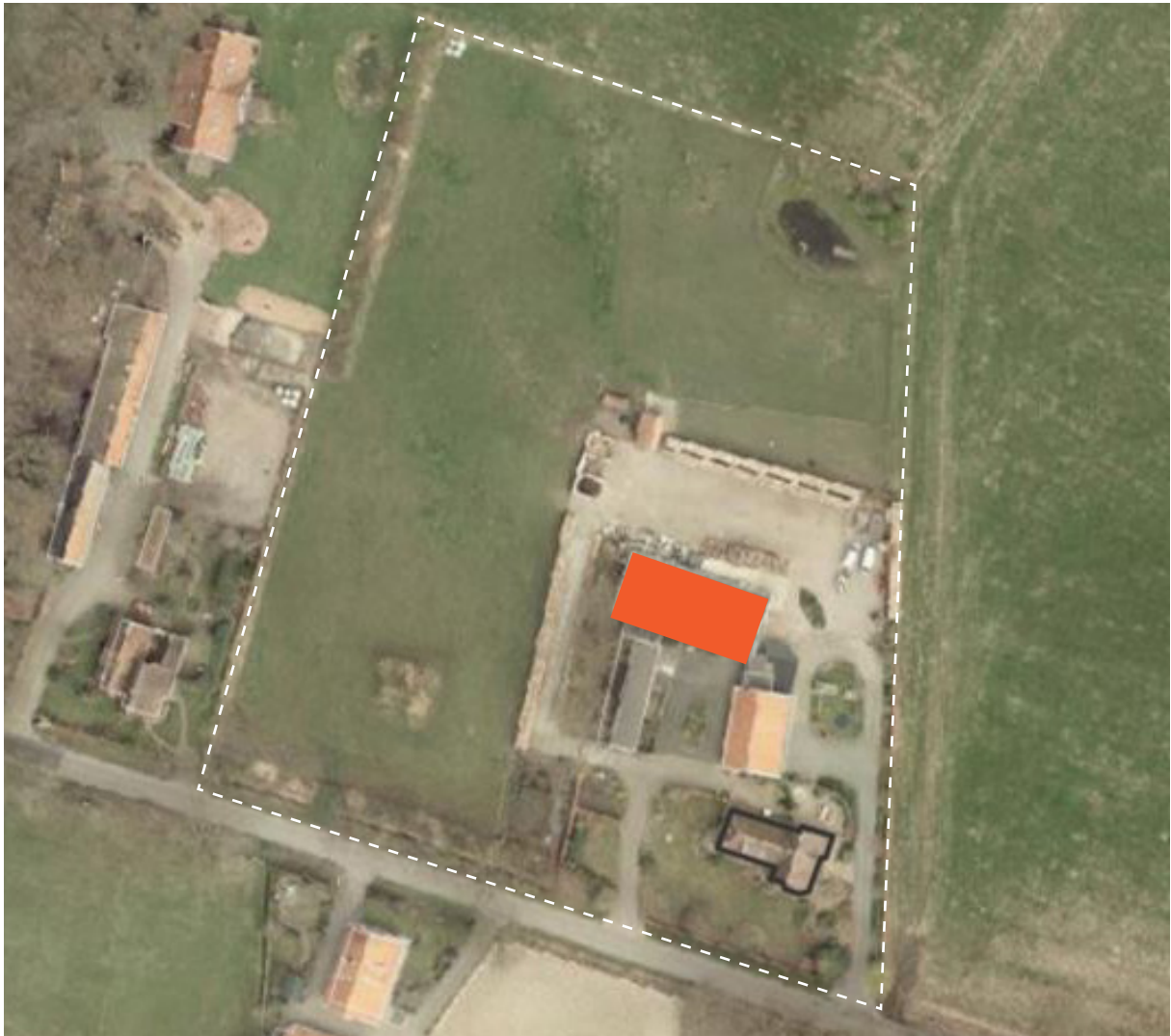
Figuur 1. Plangebied met de te verbouwen schuur
