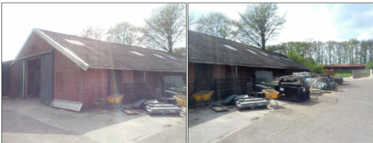
Afbeelding 2.2: Foto's te slopen schuur (Bron: In Perspectief Architectuur)
