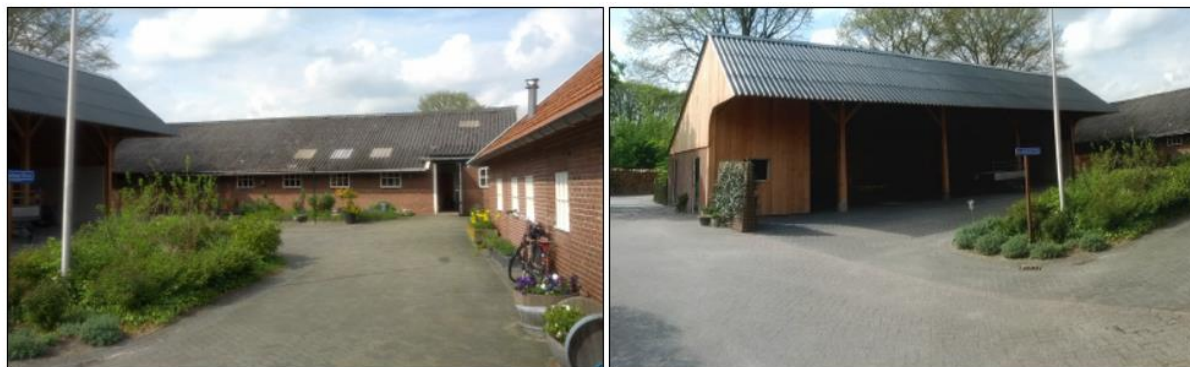
Afbeelding 2.3: Foto's te slopen schuur (zichtbaar op achtergrond) en al opgeknapte schuur (Bron: In Perspectief Architectuur)
