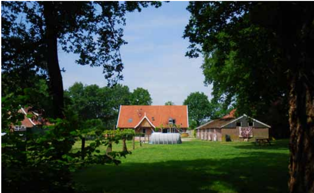
DE SCHUUR AAN DE RECHTERZIJD WORDT GESLOOPT
