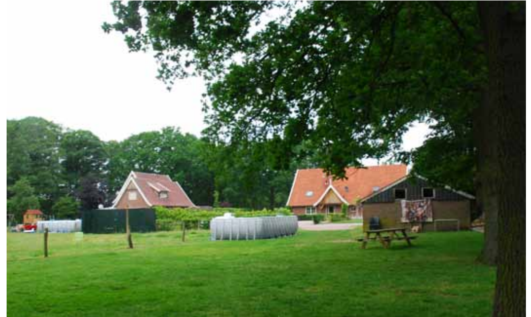
Het woonhuis, het bestaande resort en de te slopen opslagschuur
