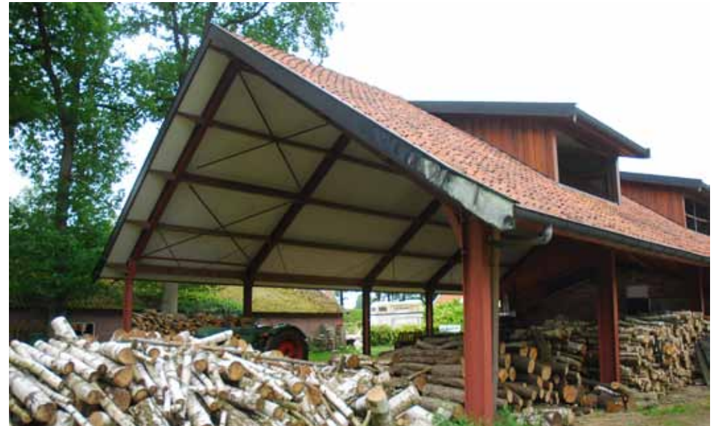
De te vernieuwen grote schuur als nieuw resort-gebouw
