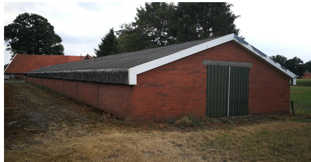
Figuur 12. Te slopen schuur 2
