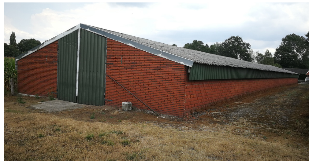
Figuur 11. Te slopen schuur 1
