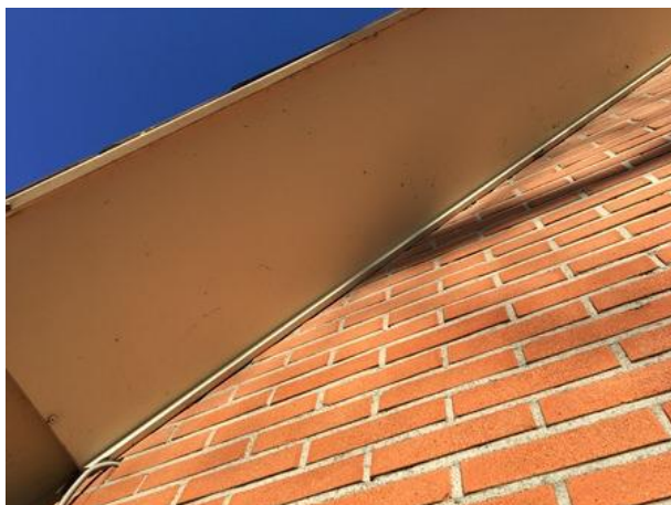
Strakke afwerking van de buitengevel van de woning; vleermuizen kunnen zo niet de spouw betreden.
